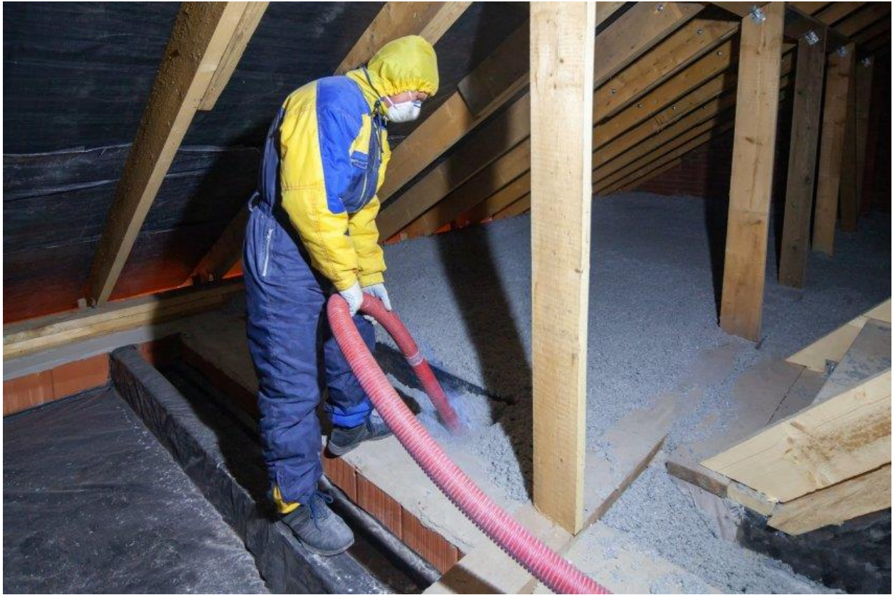
Katusealuse soojustamine puistevillaga.
